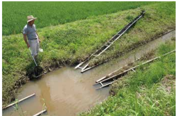
生物多様性配慮活動例：魚道
